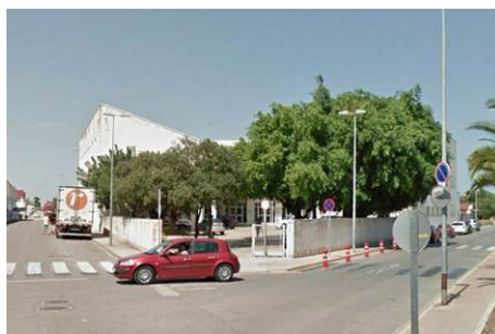
Imatge 5.22. Accés al Centre de Salut al carrer Magúncia, s/n
