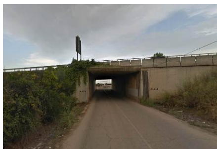
Imatge 5.96. Pas sota l'autovia A-7 de connexió del nucli urbà de Montortal amb aquesta i amb el baixador de la línia 1 de Metrovalencia
