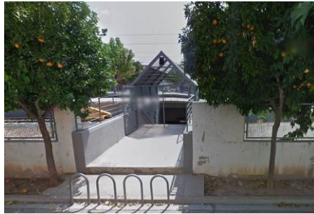
Imatge 5.75. Pas soterrani en el carrer Mestre Serrano
