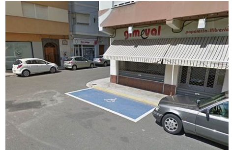
Imatge 5.119. Placa d'estacionament PMR amb deficiències de disseny i traçat al carrer de Joan XXIII
