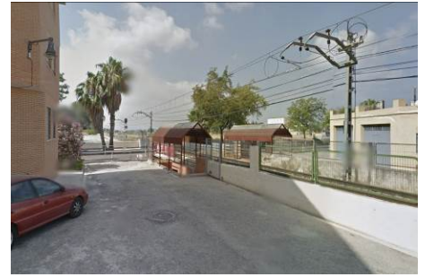
Imatge 5.76. Pas soterrani en el carrer de Resalany
