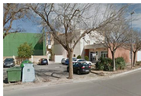
Imatge 5.19. Accés al Poliesportiu Municipal al carrer Pablo Iglesias Posse
