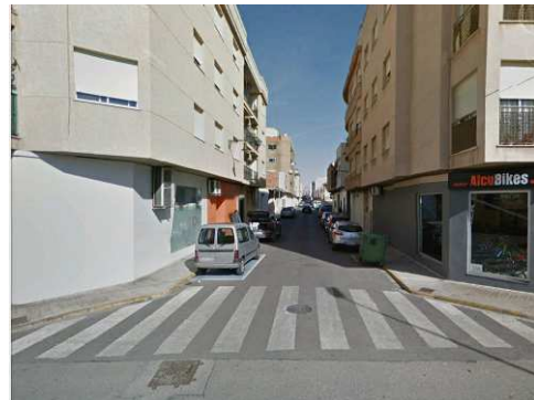
Imatge 5.48. Pas de vianants no practicable en carrer del Tribunal de les Aigües zona 3 – fira gastronòmica
