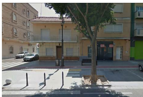
Imatge 5.59. Incorrecta ubicació de mobiliari urbà en l'avinguda d'Antonio Almela
