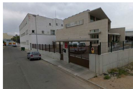
Imatge 5.23. Accés al Centre de Dia P.M.D. 'L'Alcúdia' al carrer de Magúncia, 3
