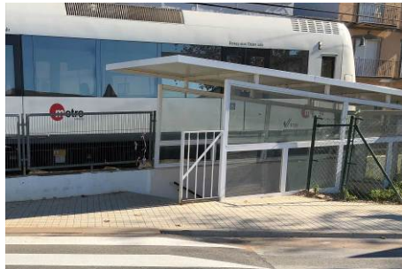
Imatge 5.73. Pas soterrani en el carrer Heretats
