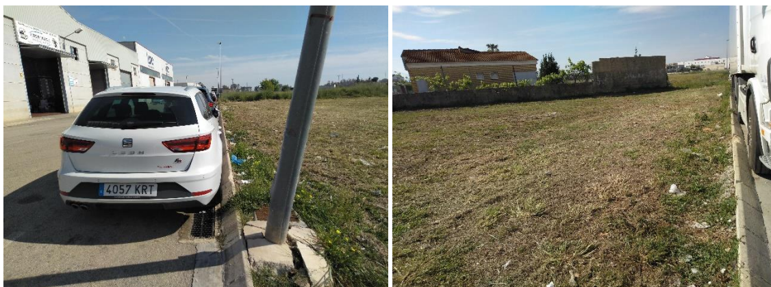
Foto 3. Estado actual del límite oeste de la actuación, junto a la calle Bollene.
