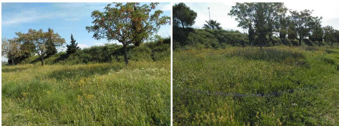
Foto 22. Duna acústica existente al este de la actuación para minimizar el ruido por la presencia próxima de la autovía A-7.
