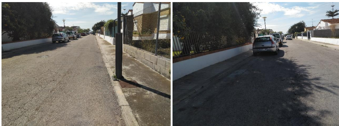
Foto 27. Estado actual de la calle Campoamor, situada al suroeste de la actuación.
