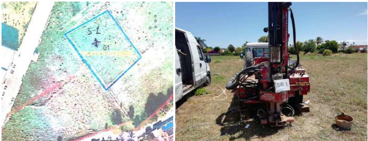
Figura 2. Situación del sondeo realizado y vista de la maquinaria ubicada.
