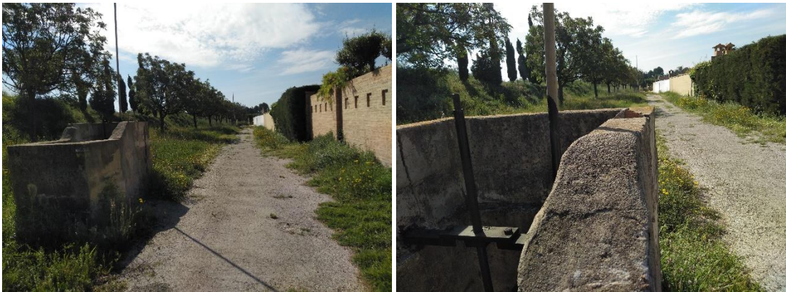
Foto 20. Camino existente al este de la actuación. Vista de las infraestructuras de riego.
