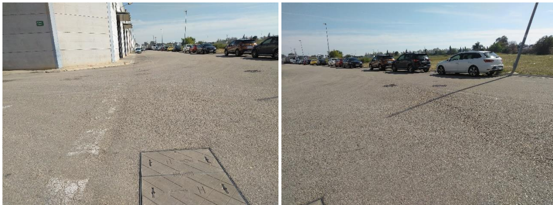
Foto 1. Estado actual de la calle Bollene, situada al oeste de la actuación. Vista norte.
