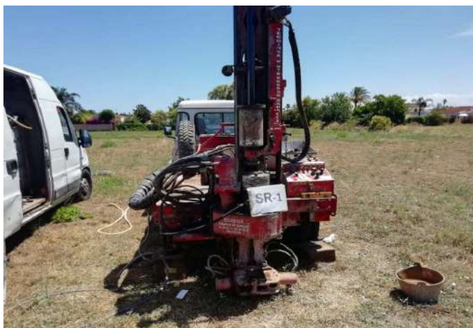
Fotografía 3: Vista del emplazamiento de la maquinaria para el sondeo S-1.
